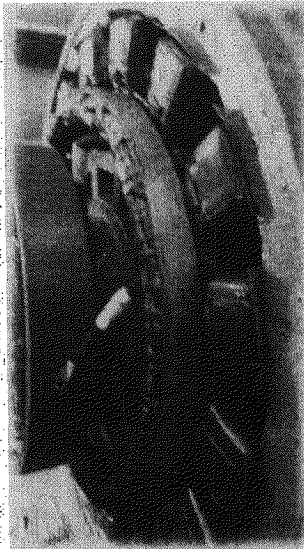
Figura 3 Excitatriz Montada no Gerador - Vista Lateral
