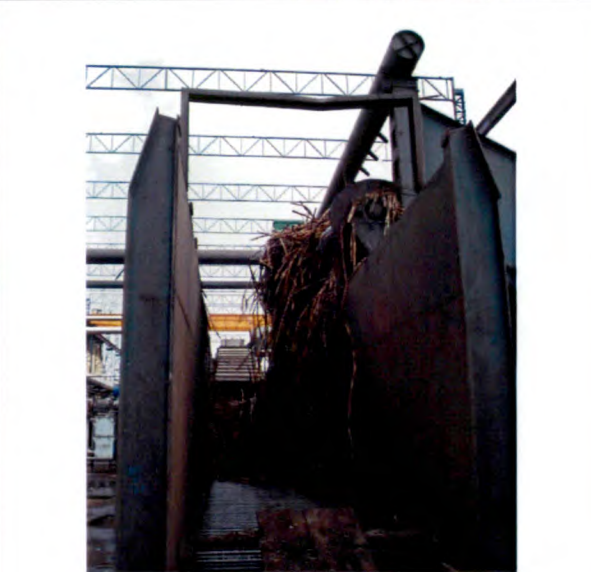
Fig.4 - Equipamento da fase de entrada
