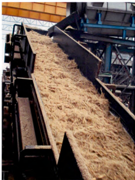
Fig.7 - Equipamento da fase de moagem
