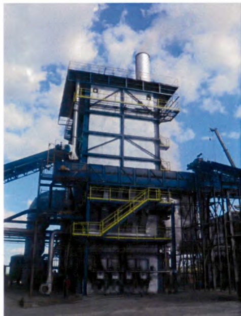
Fig.21 - Equipamento da fase de caldeiraria
